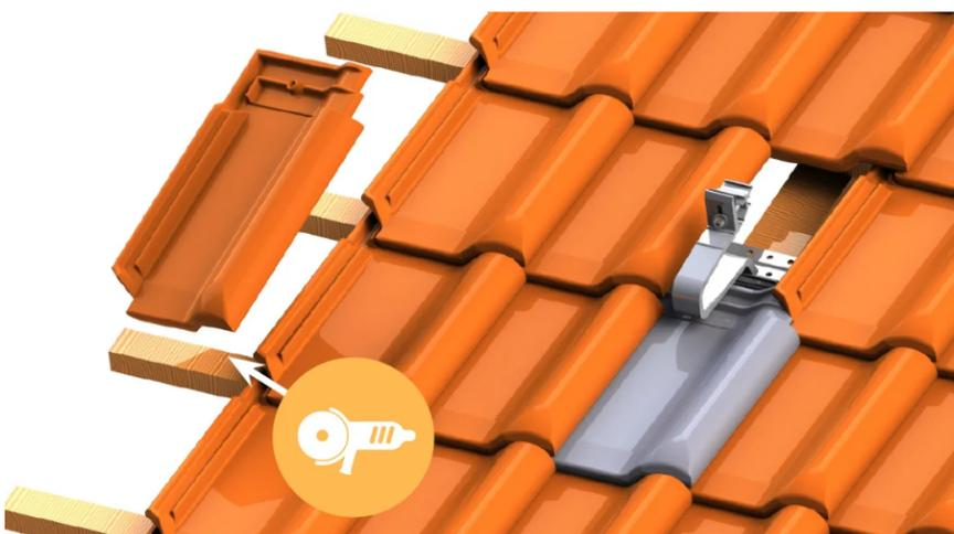
Richten Sie die Dachhaken mithilfe einer Schnur in horizontaler Richtung aus und befestigen Sie diese mit 2 Tellerkopfschrauben in den Sparren. Achten Sie dabei, dass in jeder Lochreihe eine Schraube sitzen muss.
