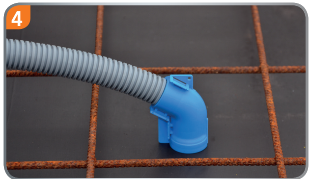
4 Auf das Unterteil stecken. Absolut sichere Zugentlastung!
