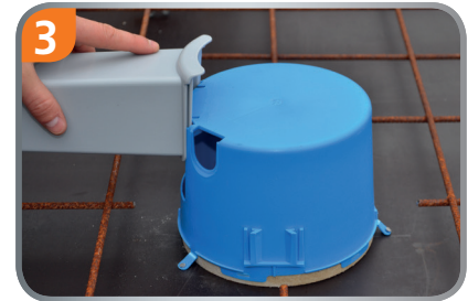
3 Trafotunnel einfach draufschieben.
