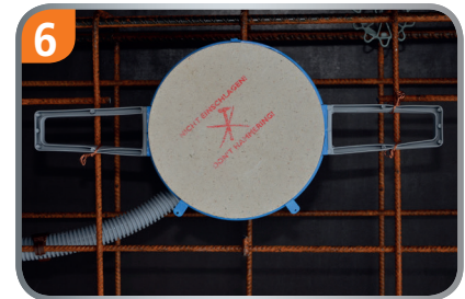
6 XL 170 ohne Trafotunnel, Montage mit Flügel.
