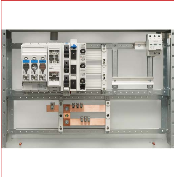
Praxisbeispiel 60mm Kupferschienensystem
