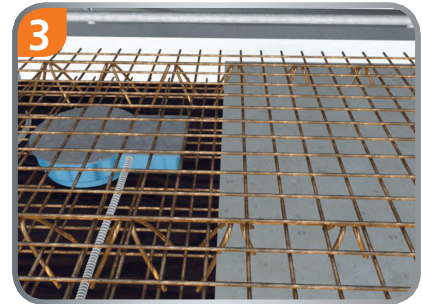
3 Insert steel strutting and pour concrete.
