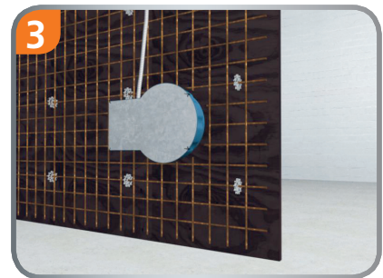
3 Installationsrohre oder Kabel einführen, dann wird der Beton gegossen.
