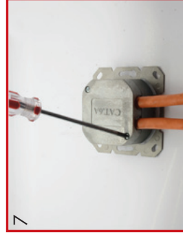
7 Rückseitigen Deckel anschrauben / Fix rear cover
