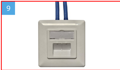
Einfachrahmen, Datendose und Zentralplatte befestigen. Fasten frame, data outlet and central plate.
