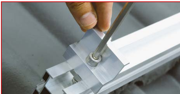
Alle Montageschritte werden mit Standard-Werkzeug ausgeführt. Nur drei verschiedene Schraubentypen erleichtern die Arbeit.
