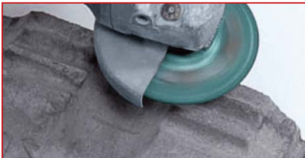
Dachziegelbearbeitung für Ausgleich der Materialstärke des Dachhakens
