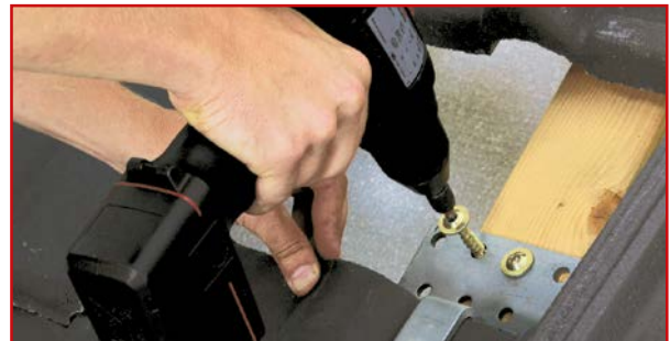
Festschrauben des Dachhakens
