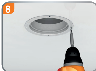
Adapterring von Luftauslass kann direkt angeschraubt werden.
