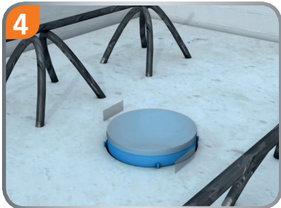
Schutzdeckel von Lüftungshülse entfernen.
