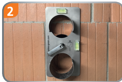
2 Bohrschablone einsetzen, ausrichten und weitere Löcher bohren.
