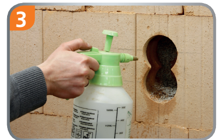
3 Bohrung anfeuchten.
