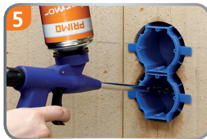
5 Dose einschäumen, durch die seitlichen Laschen ist die Putzstärke vorgegeben.
