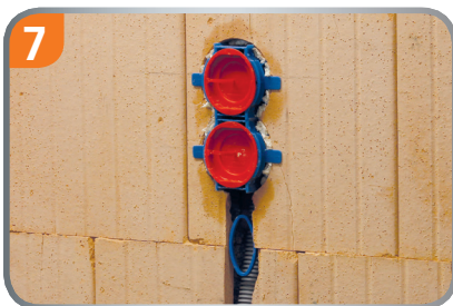
7 Rohr, Kabel einführen, Putzdeckel aufdrücken.
