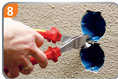
8 Nach dem Verputzen wird der SCS-Verbindungssteg ausgebrochen.
