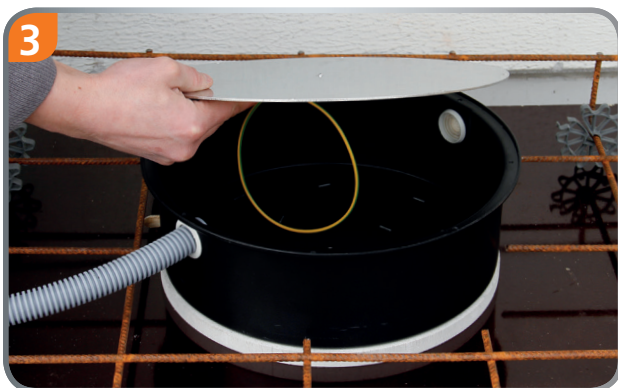
3 Rohre/Kabel einführen und stabile Blechplatte mit Kabelbinder befestigen.
